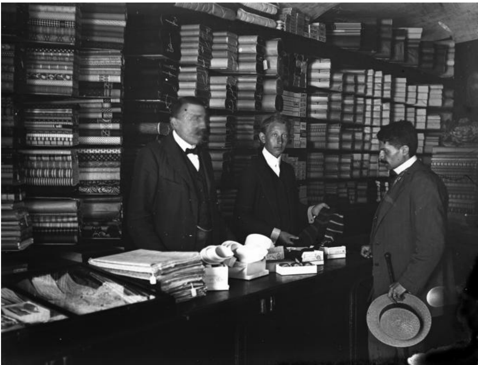
Párisi Nagyruház, Budapest, Kerepesi út [ma Rákóczi út] 38-40. (1917) Fotó:
